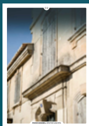
03 les façades en pierre de taille
