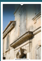
03 les façades en pierre de taille
