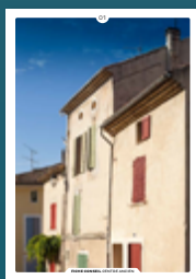
01 les façades enduites
