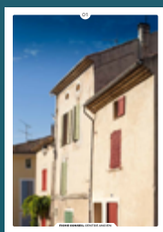
01 les façades enduites
